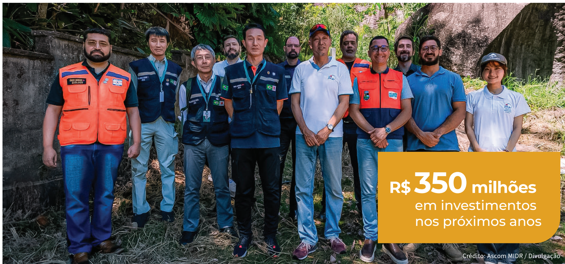
Técnicos dos Ministérios das Cidades e da Integração e Desenvolvimento Regional visitam local da construção da barreira Sabo no Morro das Duas Pedras: projeto conta com apoio técnico japonês
