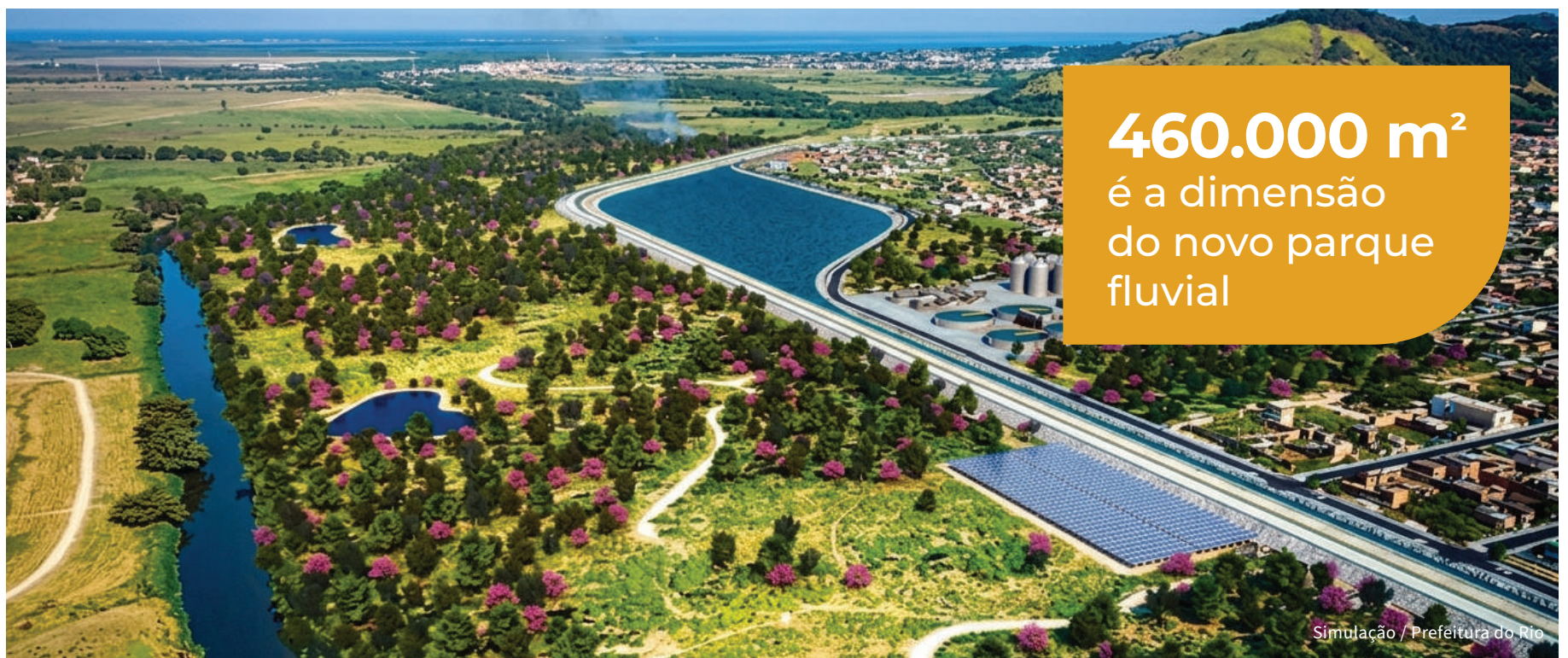
Obras para combater enchentes e beneficiar diretamente a população com urbanização integrada
