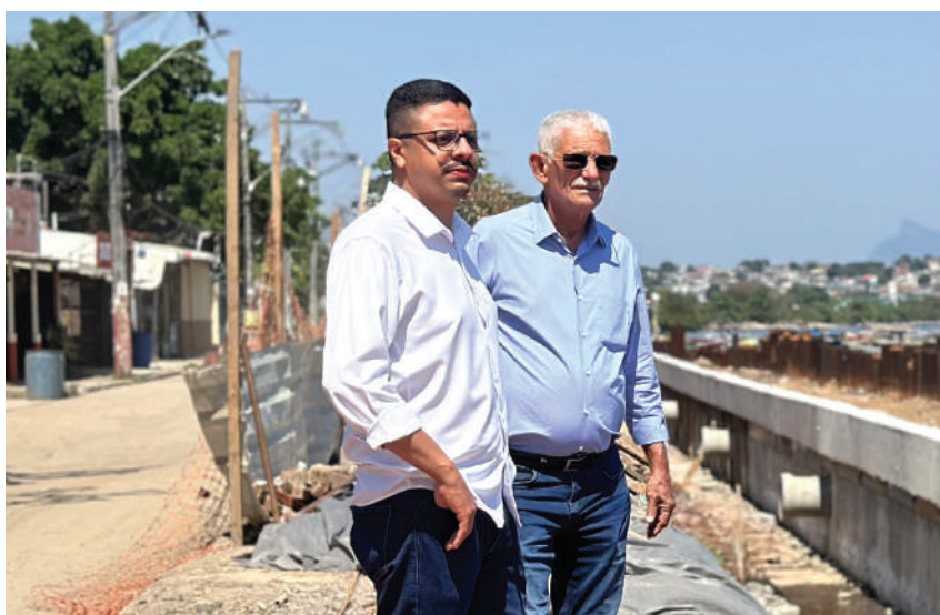
Prefeito de São Gonçalo, 'Capitão Nelson', vistoria obra inédita
