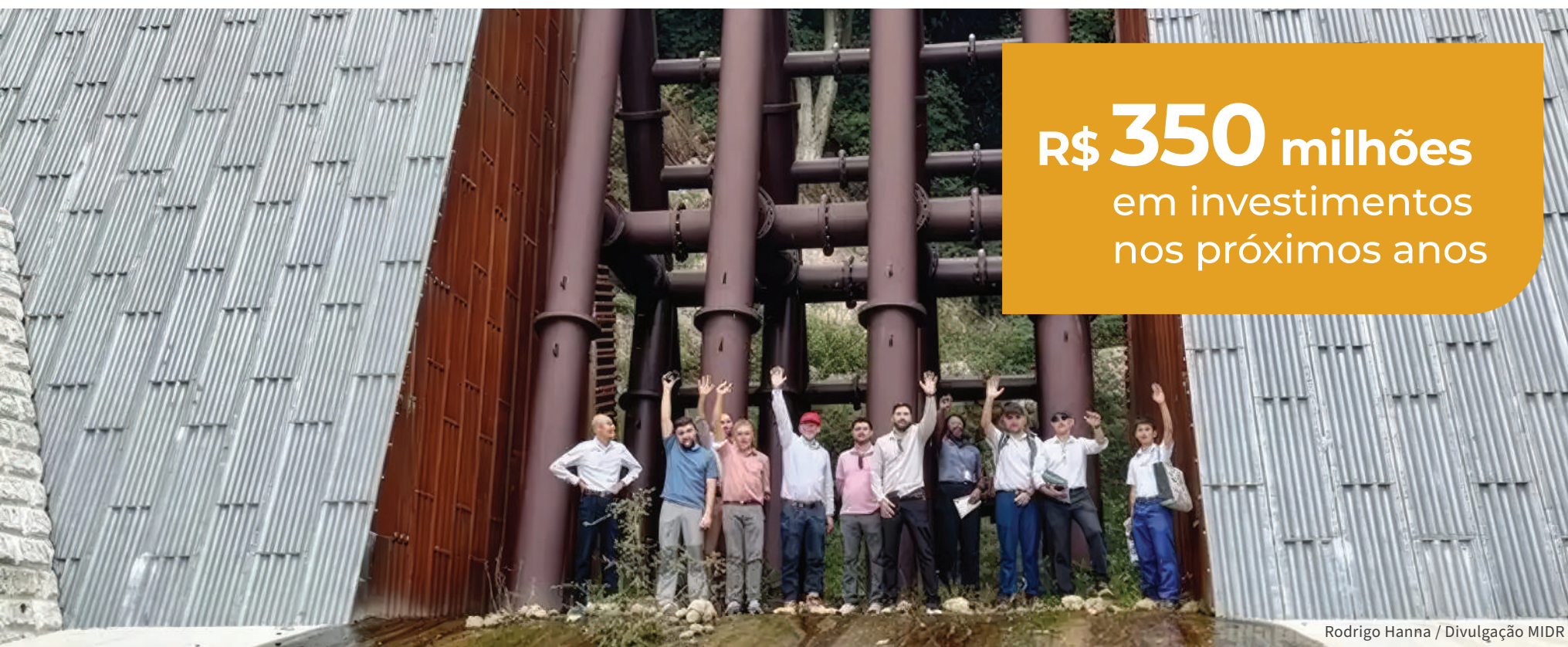
Um exemplo de barreira Sabo visitada por técnicos do Ministério das Cidades no Japão
