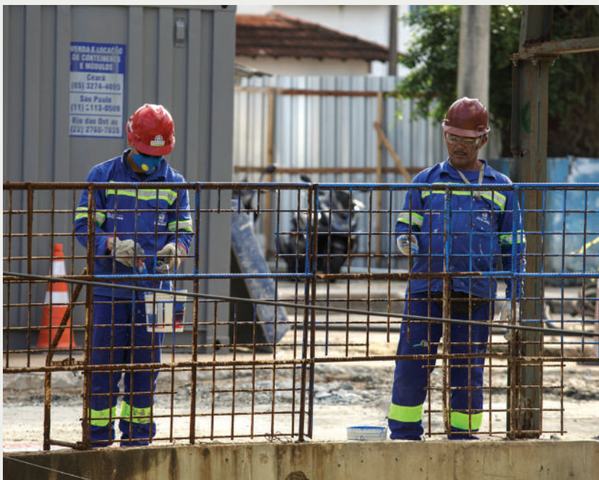
O projeto deve gerar cerca de 2.500 empregos durante sua execução. Foto: Divulgação/Setram-RJ
