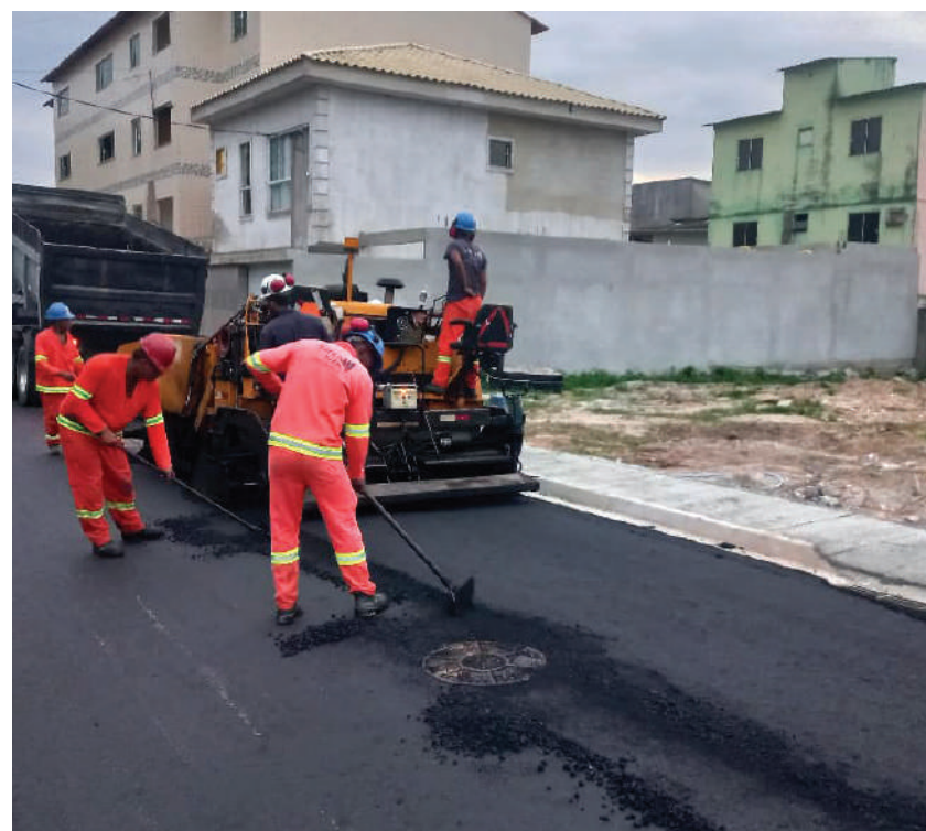
Obras de pavimentação e iluminação pública. Foto: Divulgação/Prefeitura de Macaé
