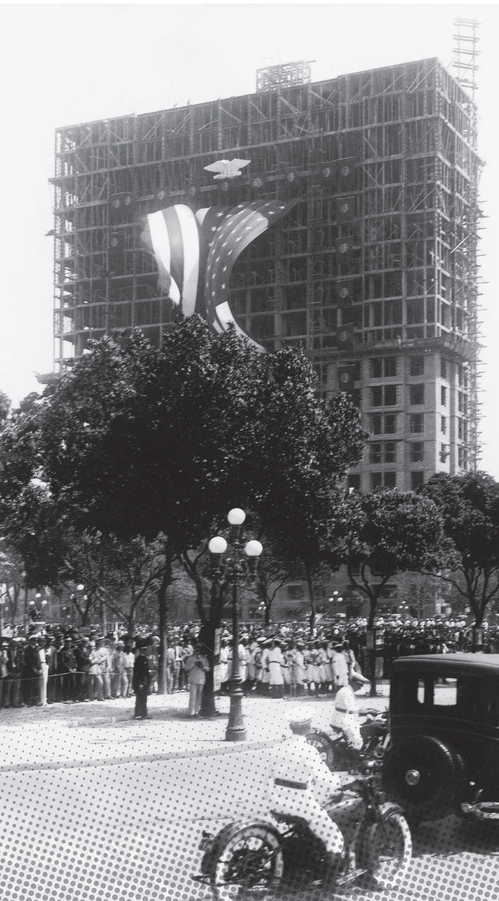
Construção do Edifício A Noite. Fonte e ano desconhecidos
