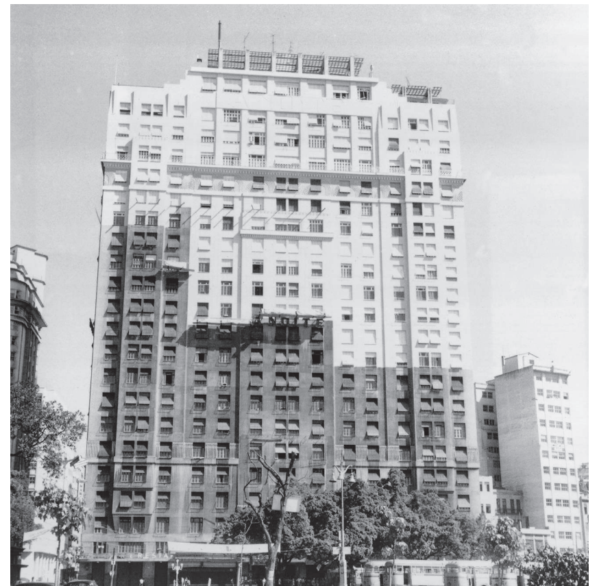
Construção do Edifício A Noite. Fonte e ano desconhecidos
