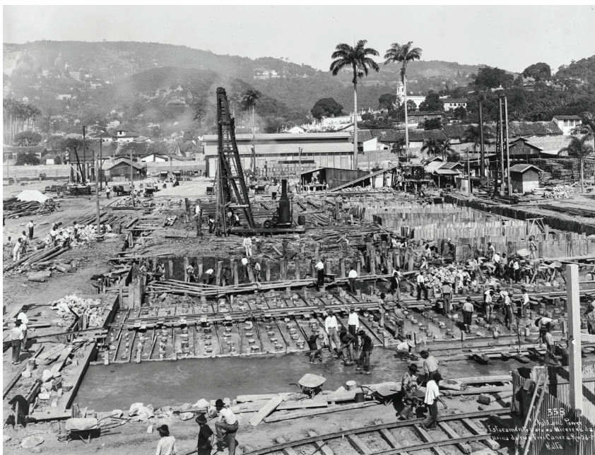
Estacamento para os alicerces da Usina da Rua Frei Caneca. Foto: Augusto Malta, 1907, Acervo Light
