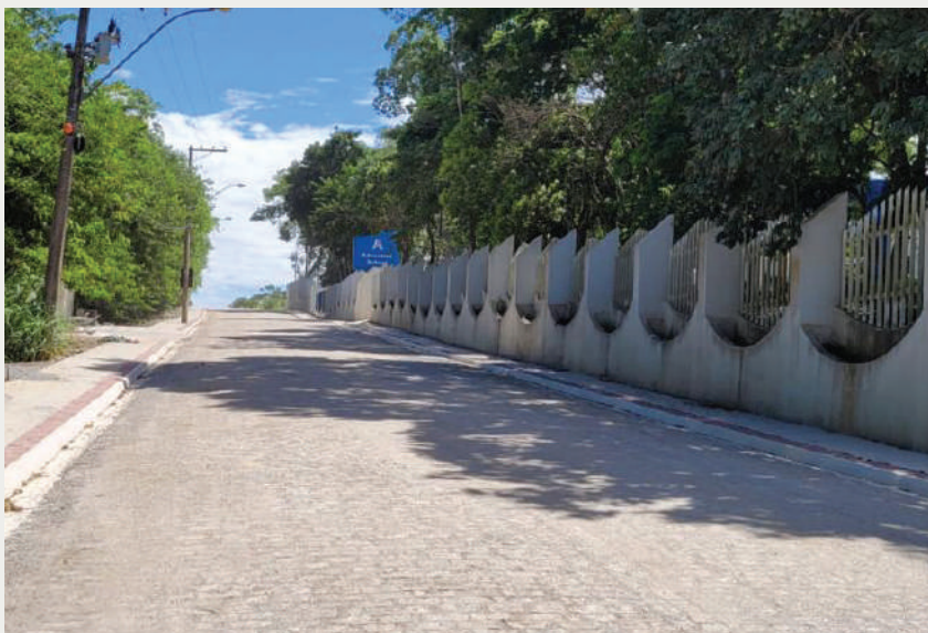
Intervenções no Vale Encantado somaram R$ 35 milhões. Foto: Divulgação/Prefeitura de Macaé
