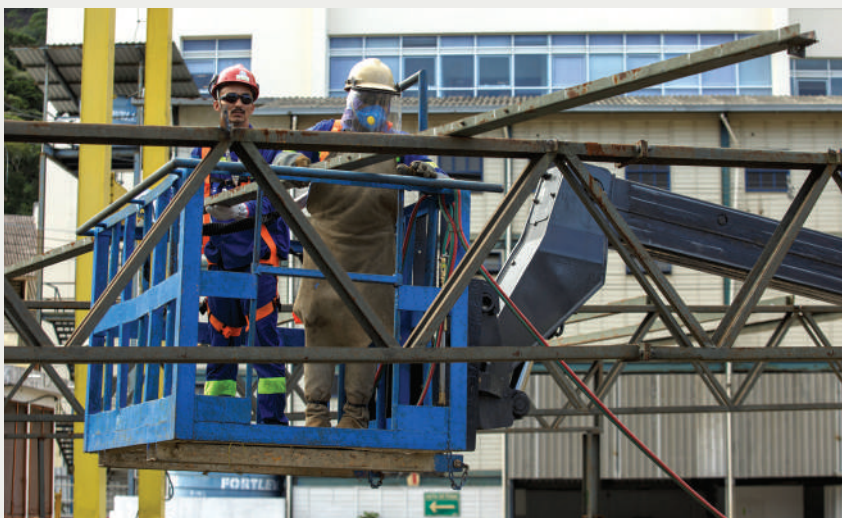
Trabalhadores soldam estruturas metálicas da futura estação do Metrô da Gávea. Foto: Divulgação/Setram-RJ
